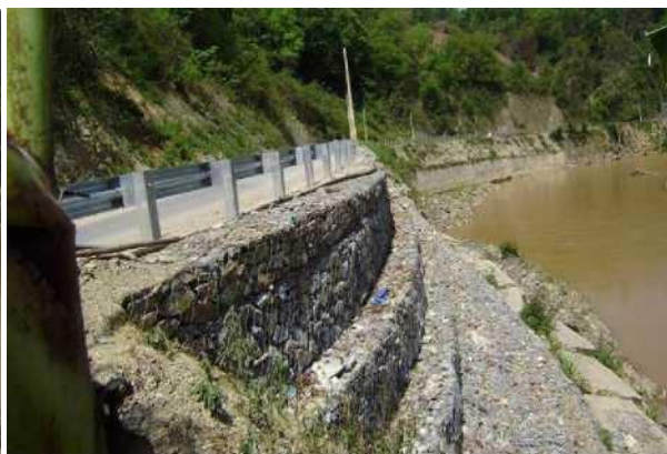
nh 17. Kè rọ đá chống xói lở bờ sông, bảo vệ Quốc lộ 7 đoạn thuộc địa phận bản Khe Nẵn, Chiêu Lưu, huyện Kỳ Sơn
