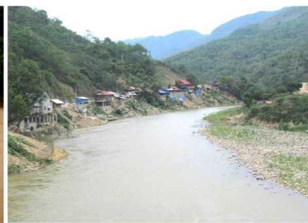
Hình 19. Xói lở bờ sông khu vực thị trấn Mường Xén, huyện Kỳ Sơn
